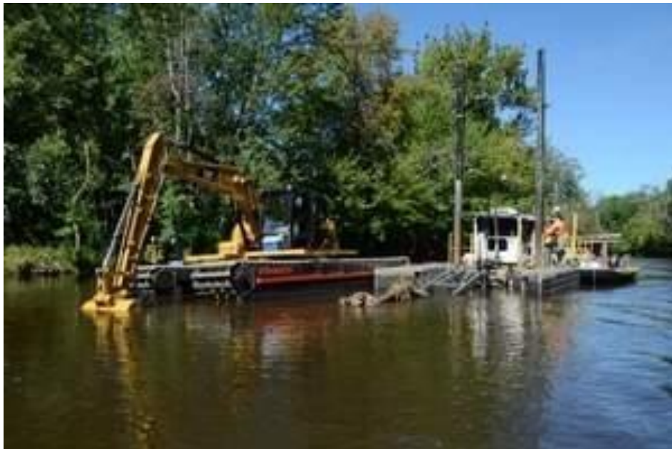
图片：星期四在位于历史悠久的桥公园和 Battle 河之间的卡拉马祖河上进行的疏浚作业现场
