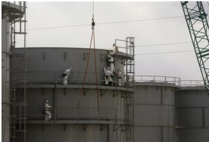
图片：在东京电力有限公司，透过汽车窗户看见穿着防护服和防毒面具的工人正在修建水箱。
