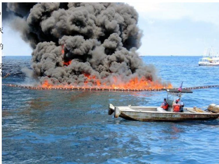
图片 8 在墨西哥湾深海地平线溢油事故中现场燃烧操作人员监测小型现场燃烧的情况（图片是由 Applied Fabric 技术有限公司提供）
